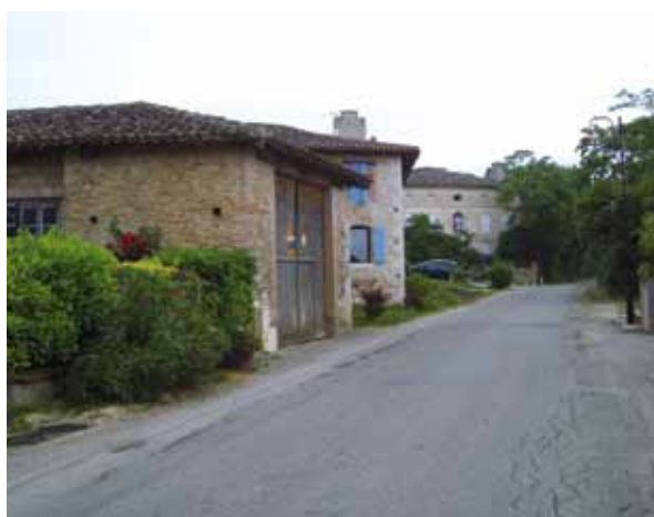
Le SDE est maître d'ouvrage de travaux couplés sur les réseaux électriques et de télécommunications éligibles au partenariat...
