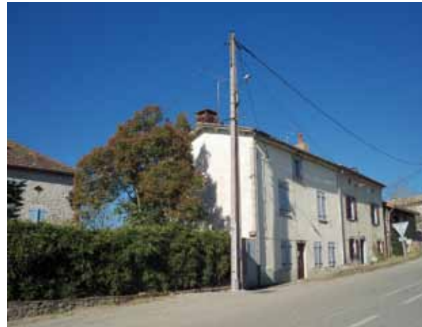
Le SDE accompagne financièrement les communes qui mutualisent leurs travaux.
