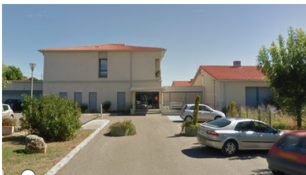
Groupement Hospitalier Vallée Quercy - Installation solaire thermique
