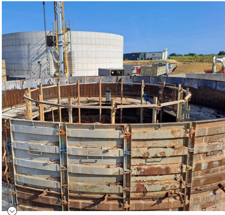
Meth'tapôle à Sérignac : construction des digesteurs
